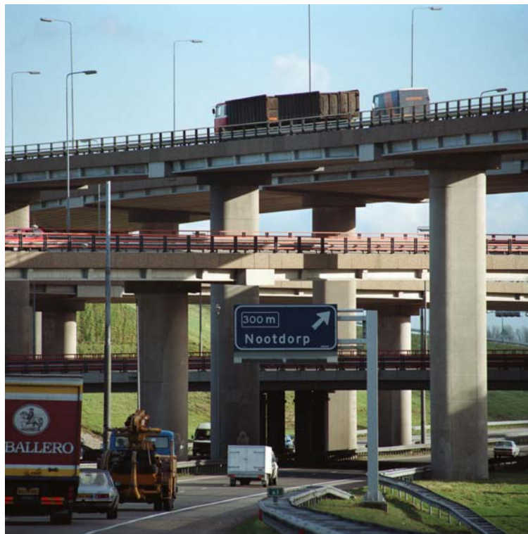
Figure 3-1 Complex 3D infrastructural object “Prins Clausplein”, The Hague. Source: Beeldbank VenW.nl
